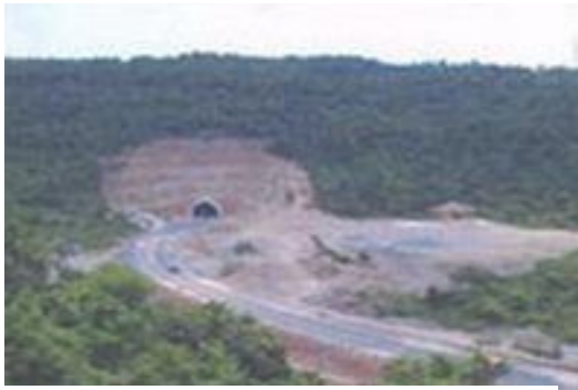
Đường vào hầm đường bộ Đèo Ngang
